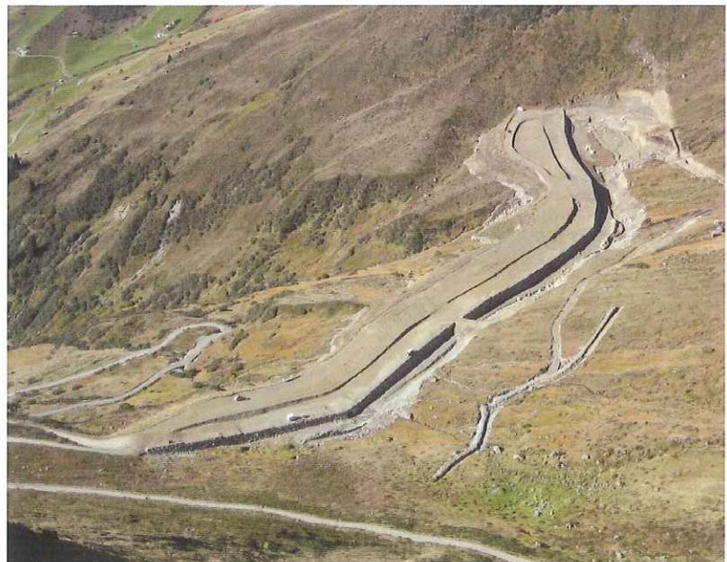
Bild 7. Dammfäche auf Höhe der innenseitigen Steinschichtung.
