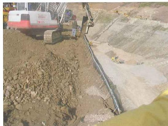
**Bild 12.** Hinterfüllung.
