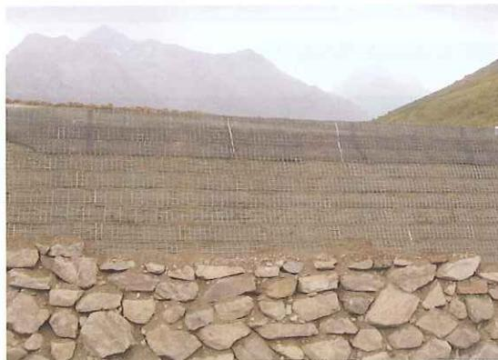
**Bild 10.** Dammböschung zum Fallboden mit Steinschichtung.
